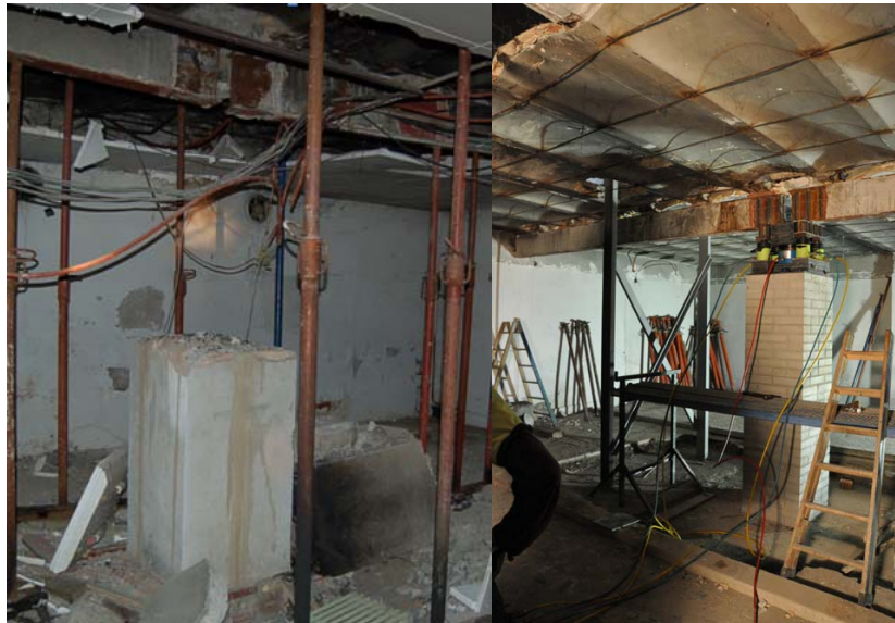
Fotografia del pilar seccionat en planta soterrani després de l'apuntament de l'estructura i fotografia de la seva restitució i aixecament del forjat mitjançant gats hidràulics (E. Dilmé).
