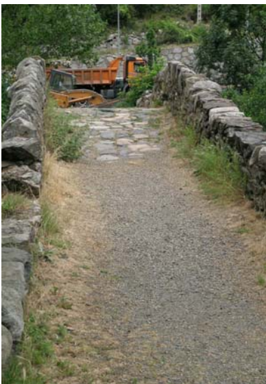
25. Estat actual del paviment del pont.
