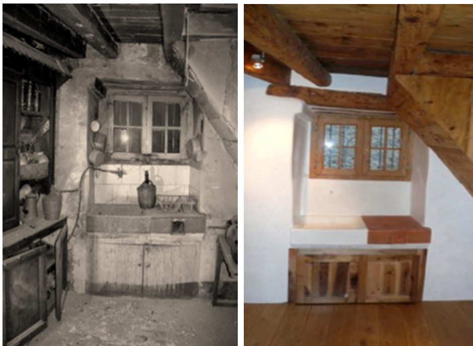
Fotografia del fons familiar de la cuina de Cal Closa a Andorra la Vella i la posterior rehabilitació. E. Dilmé, 2007.
