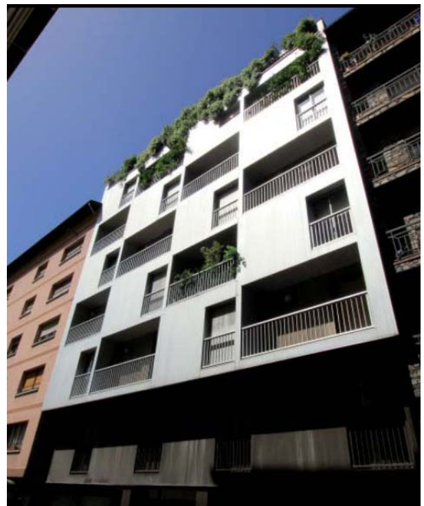
Fig.3. Alguns dels edificis interessants de la segona part del segle XX. De dalt a baix i d'esquerra a dreta, dos edificis d'habitatges a Andorra la Vella, un a Sant Julià de Lòria i el darrer a Escaldes-Engordany: 1. Vicenç Ignasi Frau Gascó (1970); 2. Armand Mas Tulla (1971); 3. Enrique Delso Calavia (1959); 4. Desconegut. Fotografies: E.Dilmé, 2012 i 2020.
