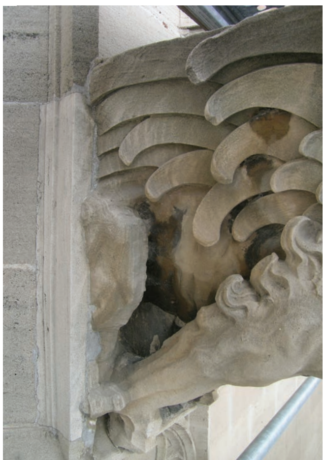
Fig. 8-9. Fotografia de la gàrgola introduïda a la façana nord en la restauració noucentista de la llotja de Mallorca; detall de l'encastament de la gàrgola.
