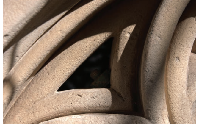
Fig. 5. Fotografia de detall d'un passador que soporta la figura original de l'intradós tribulat d'una de les traceries de la façana migdia de la llotja de Mallorca.
