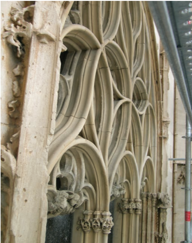
Fig. 4. Fotografia d'un dels finestrals de la façana migdia de la llotja de Mallorca substituïts a principi del segle XX.
