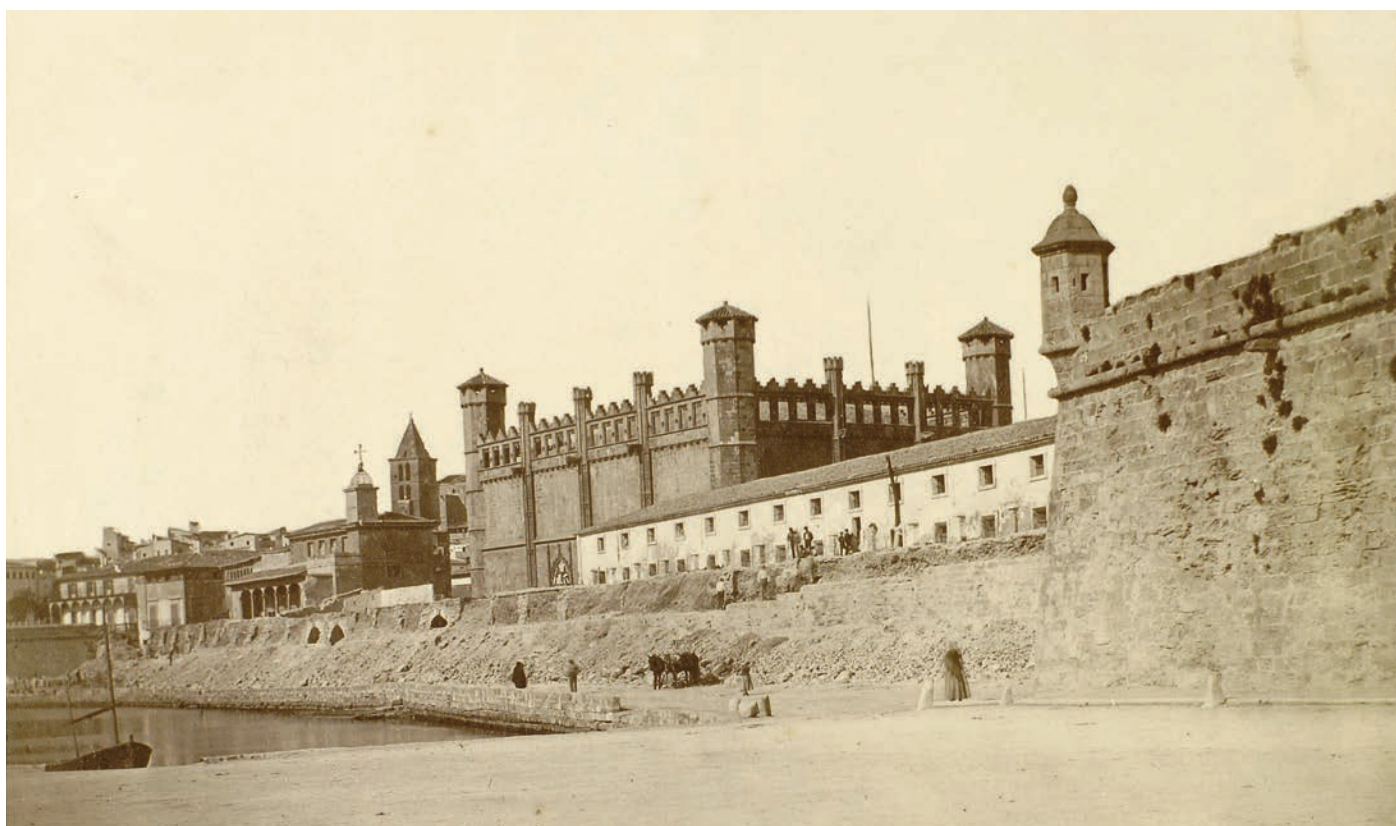
Fig. 3. Comissió de Monuments de les Illes Balears, vista de la façana marítima de la llotja de Mallorca durant el procés d'enderroc de la muralla el 1873, Real Academia de Bellas Artes de San Fernando, Archivo-Biblioteca, Fotografías Caja 27/289.
