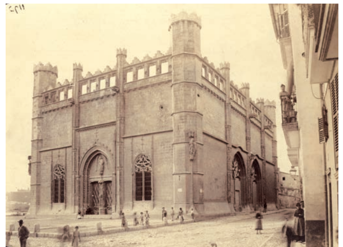
Fig. 7. J. de Lauriee, c. 1881-1893, Fotografia de la façana nord de la llotja de Mallorca on s'aprecia la manca de la gàrgola (la més pròxima a la plaça), Arxiu del So i la Imatge de Mallorca
