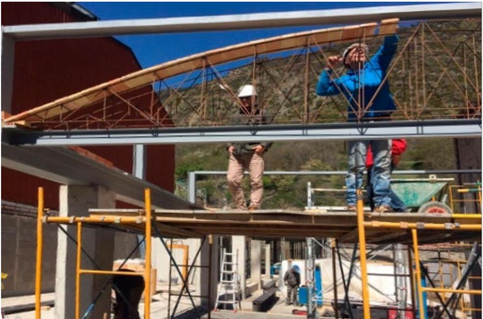
*Figura 8. Fotografía hecha durante la construcción de la bóveda donde se puede observar el inicio de la primera hilada (E. Dilmé, 2017).*
