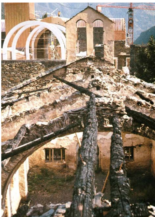
Fotografia amb el Santuari cremat en primer pla i la construcció del nou en un segon. Fotografies del llibre Construccions Mariné , 25 aniversari empresa al donem les gràcies per les vistes.
