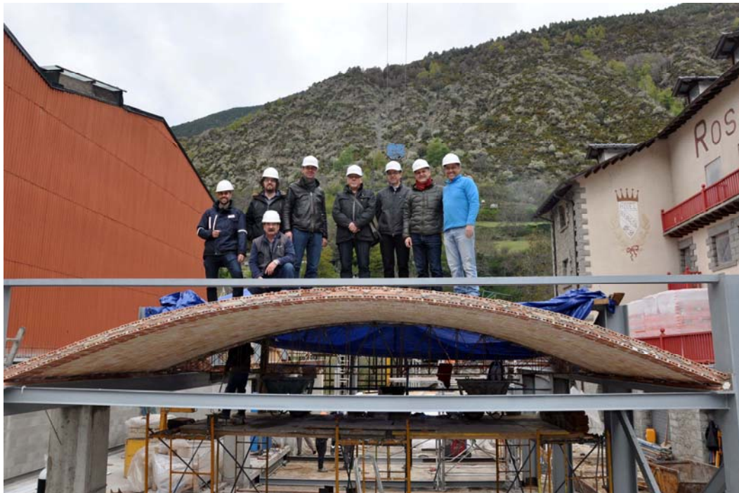
Part de l'equip tècnic sobre la nova volta de l'Hotel Rosaleda tot just acabada de començar amb el mestre d'obra Salvador Gomis a l'esquerra.
