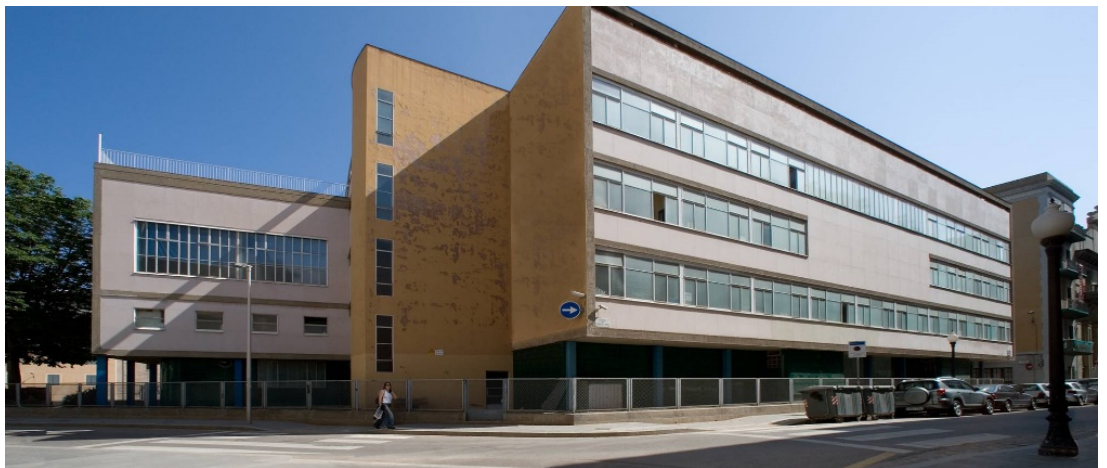
El dispensari antituberculós de Barcelona obra de Sert, Clavé i Subirana
