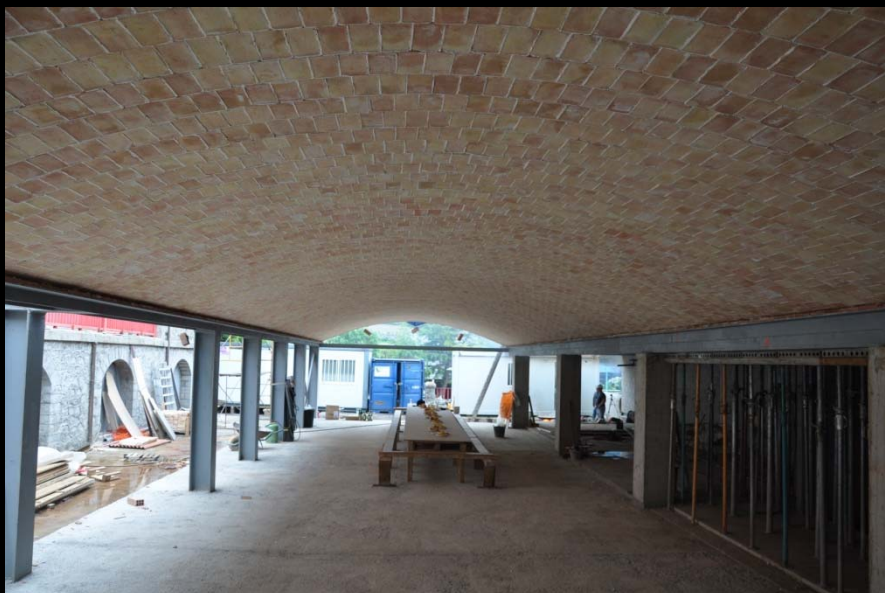
Vista de la nova volta de l'hotel Rosaleda d'Encamp, tot just acabada amb la suggestiva tesxtura i variació cromàtica
