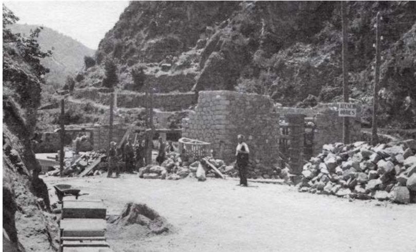
Construcció de la fàbrica de blanqueig (pells) de J.Pantebre, 1946. Bastides i cindris per vestir l'edifici, característic de la construcció històrica (X.Pla i Pujol, 1906/1966, Publicacions COAA, núm.84,2005).
