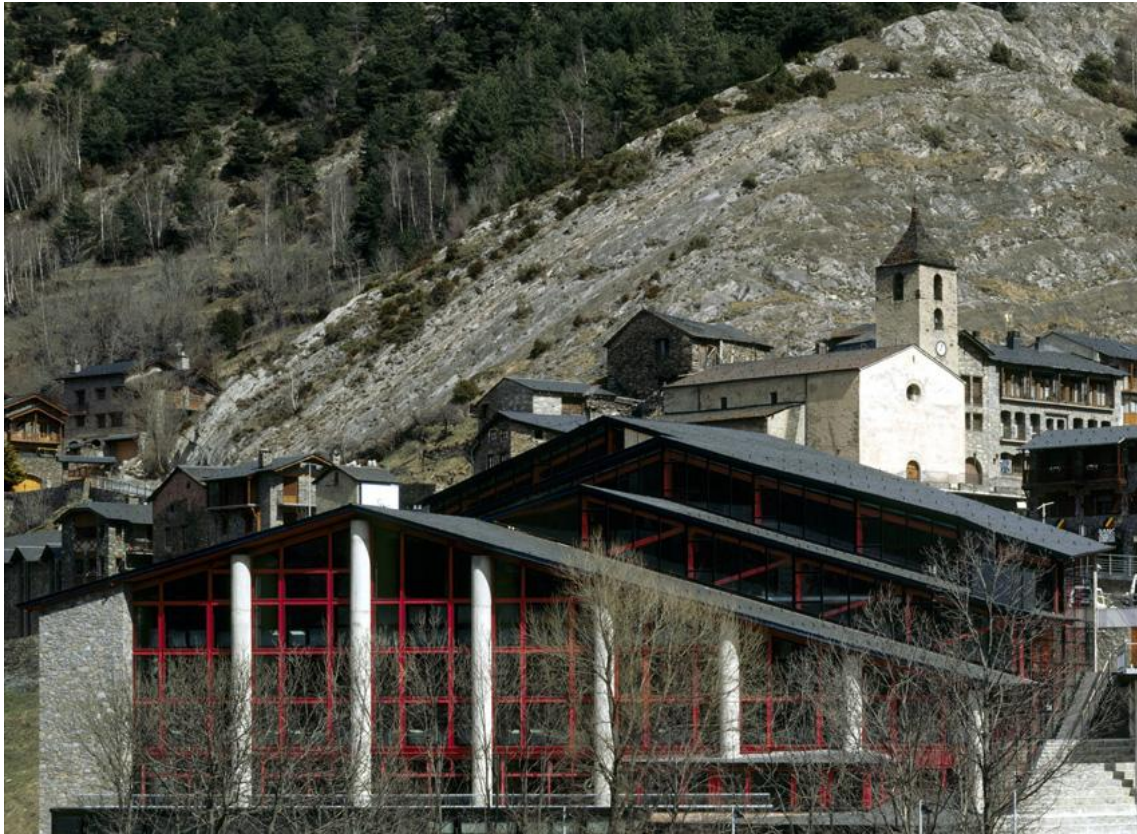
Fotografia frontal de centre esportiu amb l'església de Sant Corneli i Sant Cebrià la fons (mbmarquitectes.cat). Podem veure el joc de cobertes a dos aiguavessos que cerquen adaptar-se a la fisonomia local.
