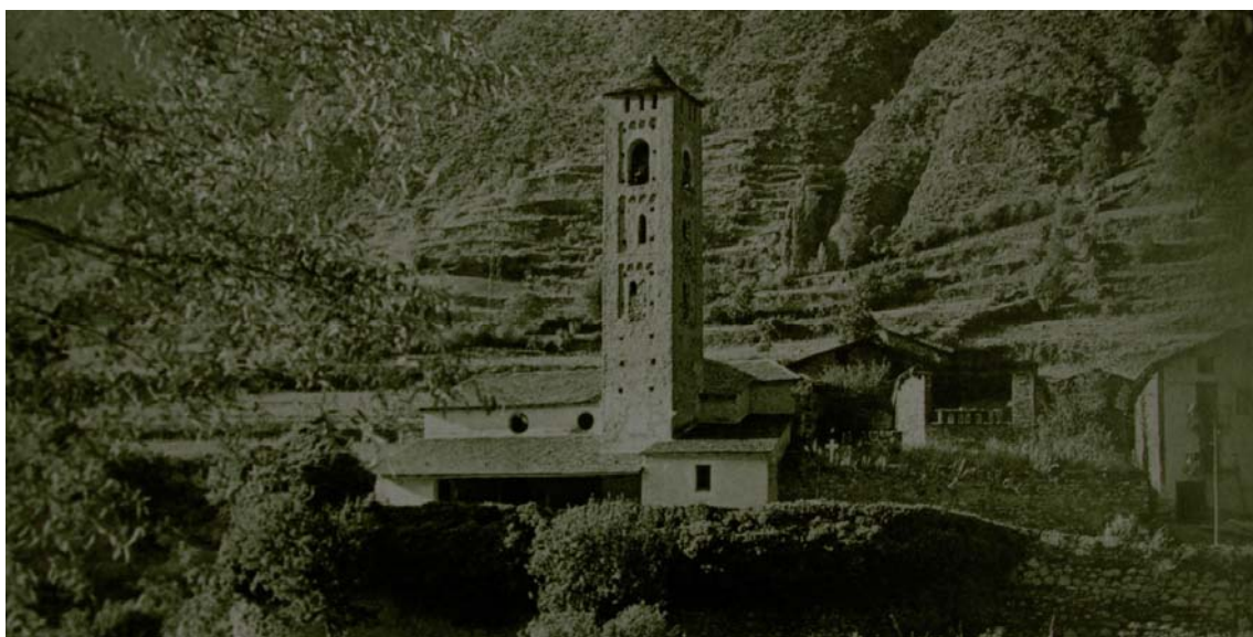
Vista de la façana de migdia de l'església abans de l'ampliació de finals del segle XX. Es pot veure encara el cementiri del costat de tramuntana
