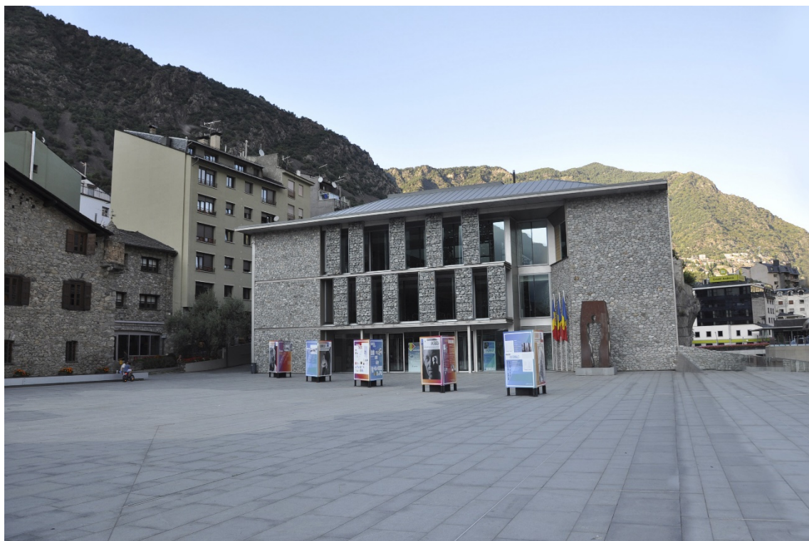
Fotografia de l'actual plaça de la Vall amb la casa de la Vall a l'esquerra i l'edifici del Consell General al centre (E. Dilmé, 2018).
