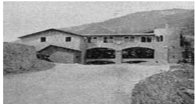
Imatges de les obres en construcció. La part superior de la torre de Babel i el primer pis de Ràdio Andorra. Una creix descompensada i l'altre per nivells.
