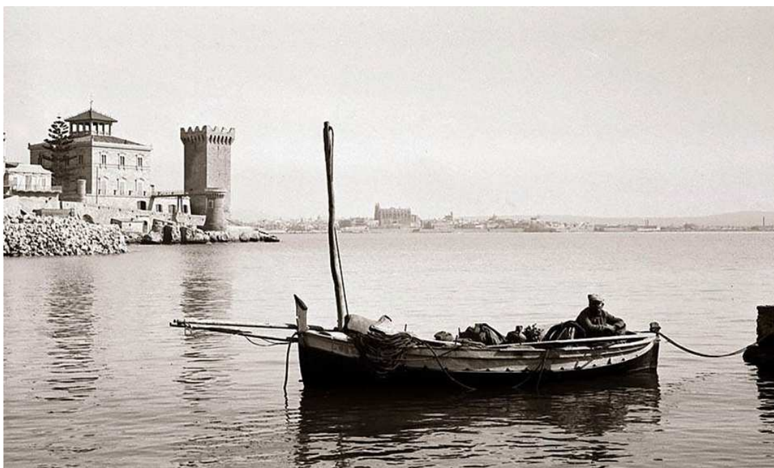
La torre de Peraries, a la dreta de la casa d'estiu de can Salas, amb la Catedral de Mallorca al fons. Finals del segle XIX (FAM, arxiu fotogràfic F. Moragues). La insistència de la Comisión de Monumentos Balear va salvar la torre de Perares de la desaparició pagant amb fons propis la seva restauració (Cantarellas, 2008: 56).
