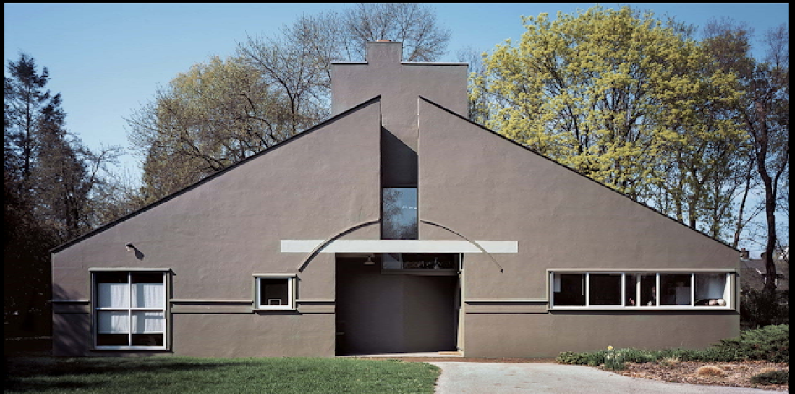
Casa Vanna amb una coberta a dues aigües i un arc sobre l'entrada (foto estreta de la web arquitectural)
