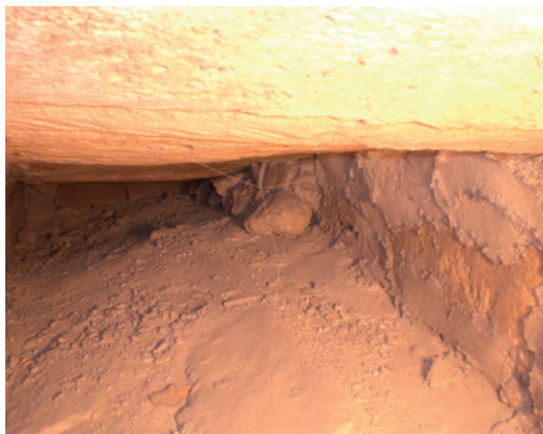
6-7. Llotja de Palma: alfàbies que omplien els carcanyols de les voltes i mitjans per rebre el trespol de la coberta (fotografies de J. Izquierdo, 2008).
