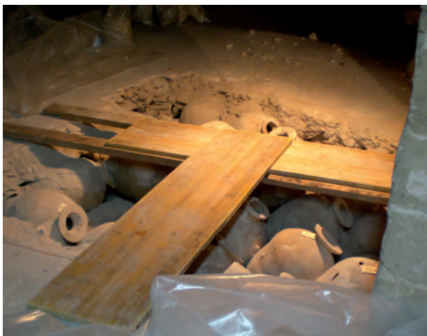
6-7. Llotja de Palma: alfàbies que omplien els carcanyols de les voltes i mitjans per rebre el trespol de la coberta (fotografies de J. Izquierdo, 2008).
