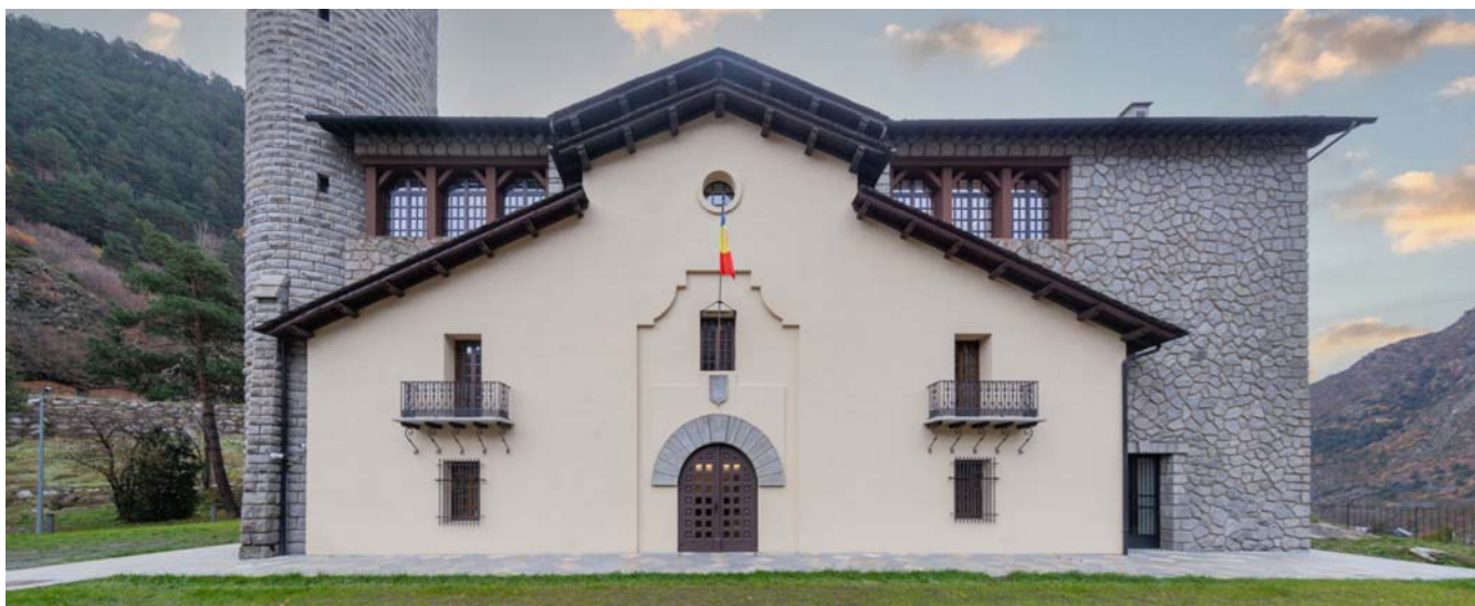
Façana nord de Ràdio Andorra després de la restauració. Fotografia ArtdeViure, 2022.
