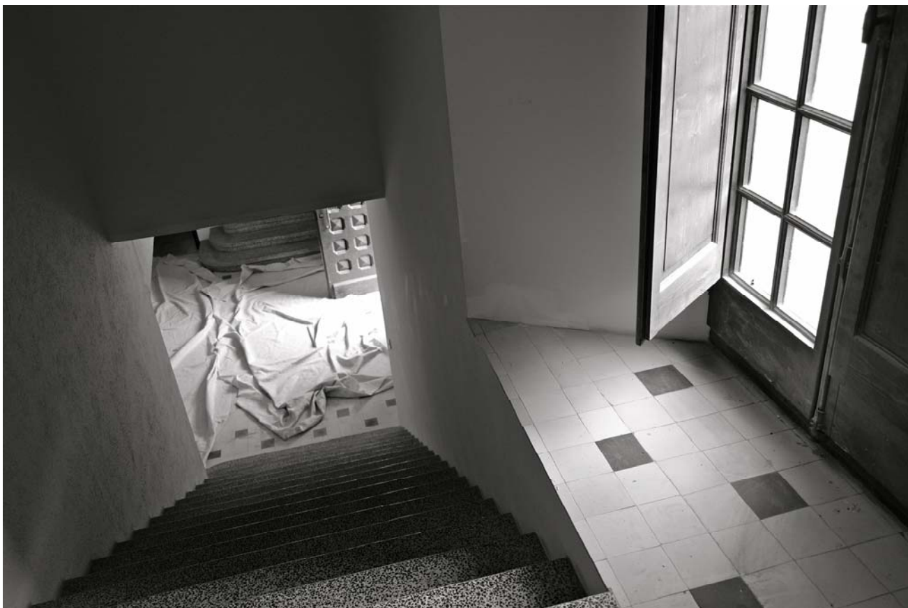
Escala que va cap a la porta de la torre amb d'accés al balcó. Foto J. Vilaplana, 2017.
