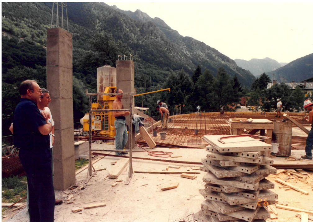
Yves Serra, a l'esquerra de blau, en una visita d'obra a l'edifici Aixàs d'Andorra la Vella de Pere Aixàs, 1992. (Foto cedida pel mateix arquitecte).
